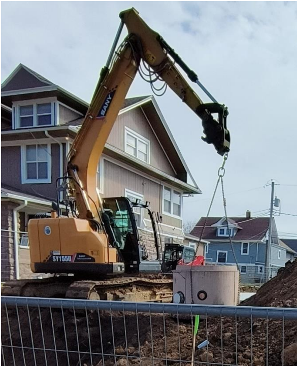
Sewer Manhole
